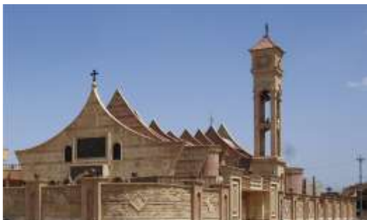
Karakosch, vom IS zerstörte und wieder aufgebaute Kirche Behnam und Sarah
